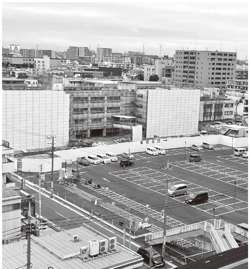
新庁舎の建設状況
