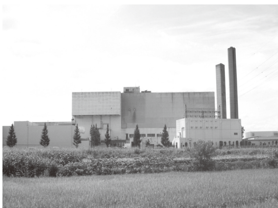
戸塚環境センター 東棟
