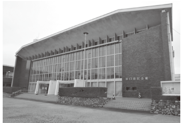
平成28年度解体になる耐震力不足の市民会館
