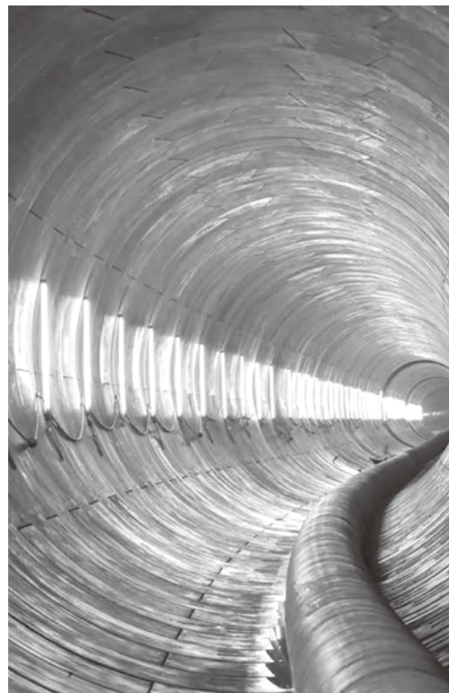
※大雨の時下水道施設で流し切れない水を一時的に取り込む雨水貯留管の内部。その量小学校の25メートルプール約20杯分
